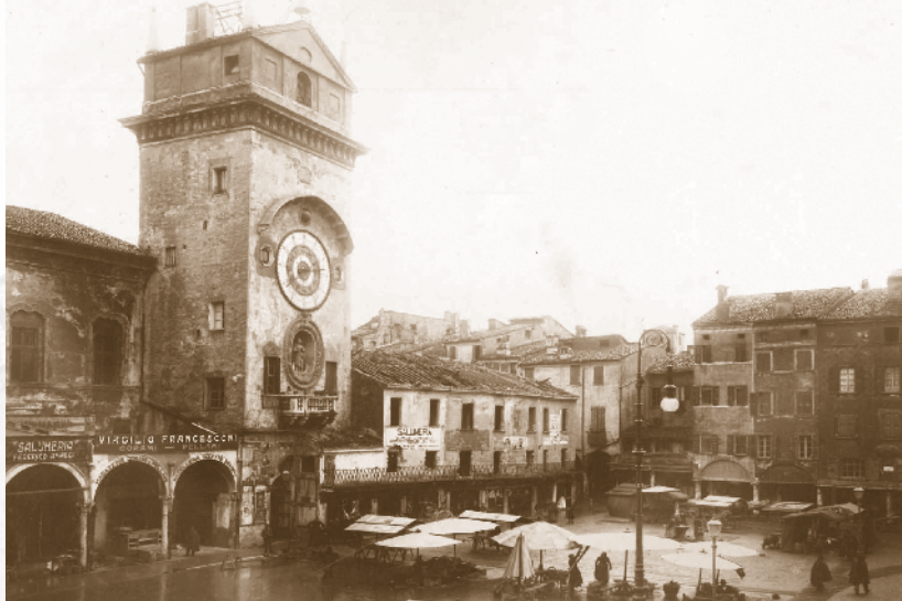
Piazza Erbe prima della demolizione delle case intorno alla Rotonda di San Lorenzo (ASCMn, Raccolta fotografica, cart. 16; fasc. 2/2, foto 1, aut. 2/2017)
